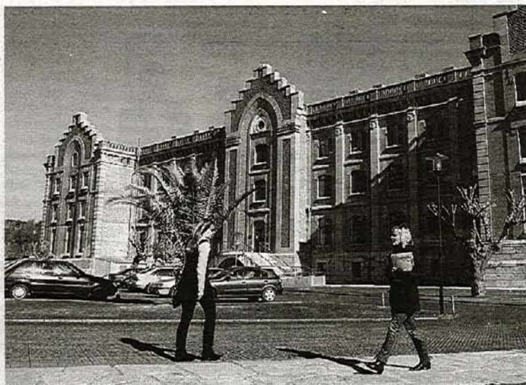
Edificio que ocupa la Uex en el antiguo cuartel. / PALMA
