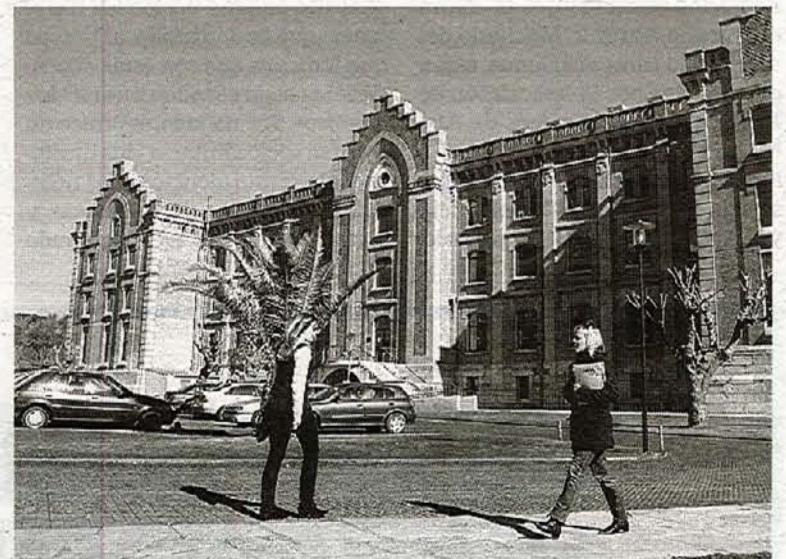
Edificio que ocupa la Uex en el antiguo cuartel. / PALMA
